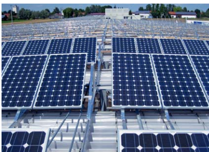
Aufbau einer großen PV-Aufdachanlage
