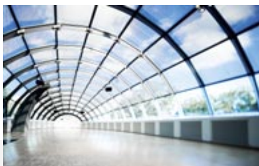
Schloss Montabaur: Semitransparente Photovoltaikmodule ermöglichen neben der Stromerzeugung auch die Verschattung (Bild: Glas Wagener)
