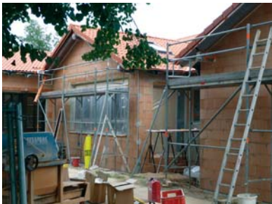
Bild 3: Die Verarbeitung der Wärmedämmfassade Poroton-WDF erfolgt im Planziegel-Verfahren – einfach und sicher.
