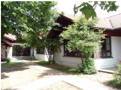
Bild 2: Kindergarten Waldetzenberg vor der Sanierung: ein schlecht gedämmtes Gebäude, erstellt Anfang der 80er Jahre.
