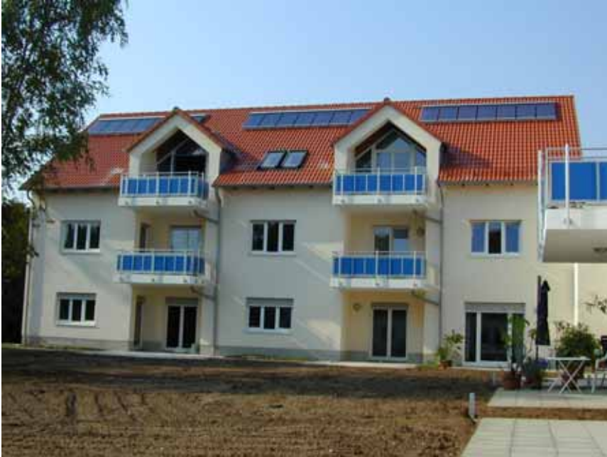
Mehrfamilienhaus Amberg Solare Heizungsunterstützung 65 m 2 Vakuumröhrenkollektoren, 2003
