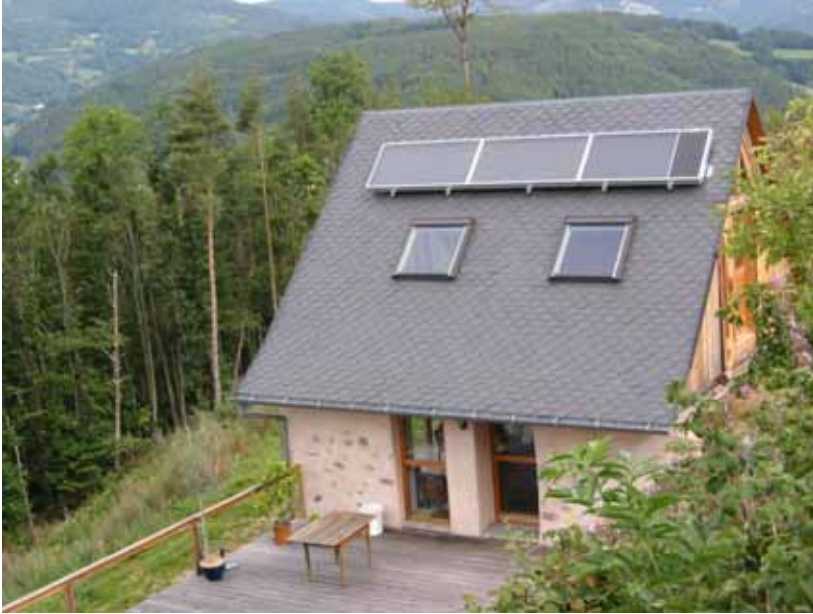
Wohnhaus Vogesen, 6 m 2 solarautarke Energielüftung
