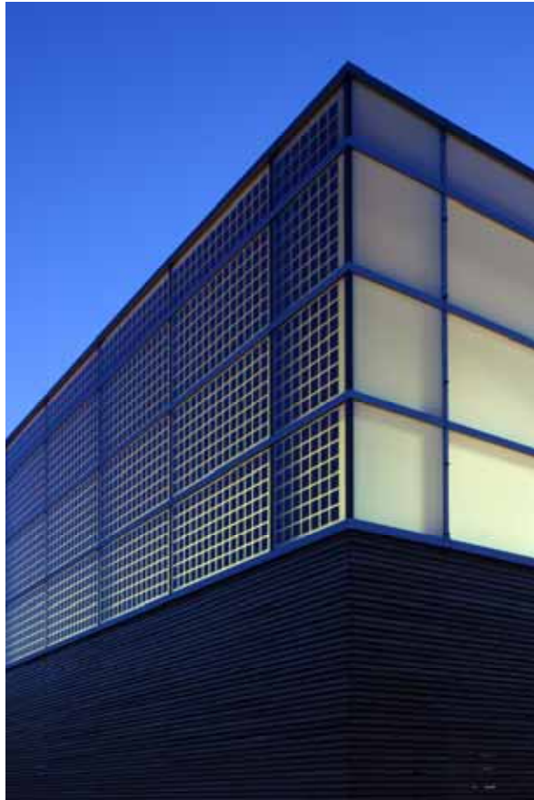
PV-Fassade, Regensburg 100 m 2 , 10 kWp, 2004
