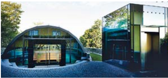
Das neue Tagungszentrum des Schlosses Montabaur: Eine Photovoltaikanlage und eine Erdwärmeheizung machen das Veranstaltungszentrum energetisch autark
