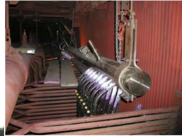
Dampfleitung mit 700 °C Frischdampf
