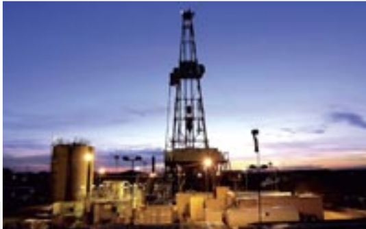
Das in Sauerlach zur Energieerzeugung genutzte Thermalwasser ist heißer als erwartet, die förderbare Menge liegt jedoch unter den Erwartungen (Bild: SWM)
