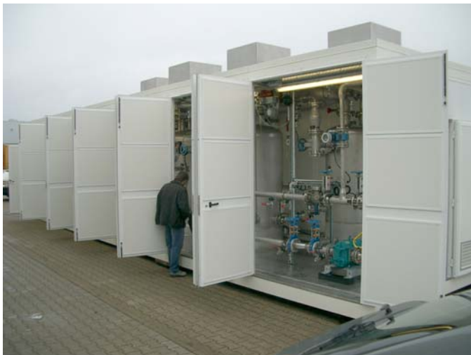
Bild: Seitenansicht Thermische Hydrolyse mit geöffneten Zugängen
