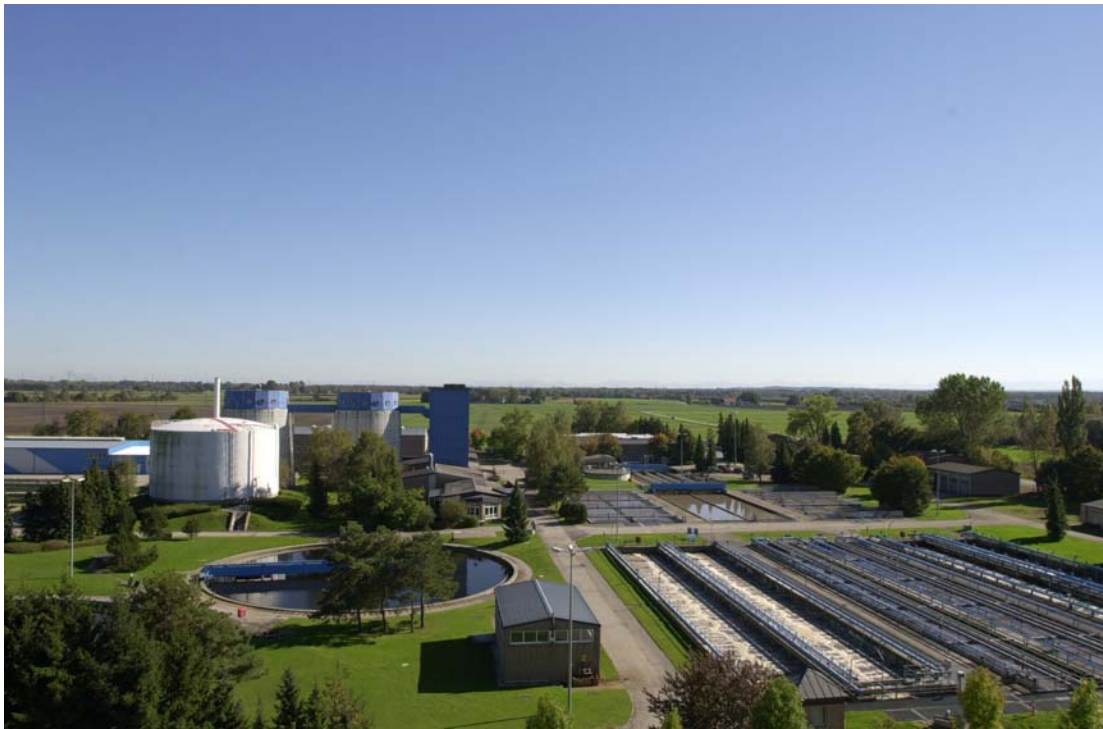
Bild: Gesamtansicht Kläranlage Geiselbullach, Amperverband
