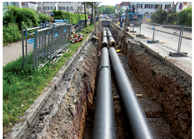
Verlegung einer örtlichen Fernwärmeleitung
