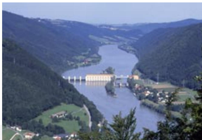
Die technischen Anlagen des Pumpspeichers Riedl werden zum Teil auf dem Gelände des Donaukraftwerkes Jochenstein entstehen; die Geländemulde für das Oberbecken befindet sich oberhalb der Hügel (Bild: Donaukraftwerk Jochenstein AG)
