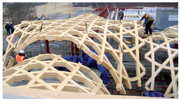
Vision aus Holz – einzigartige Architektur für eine Dachkonstruktion
