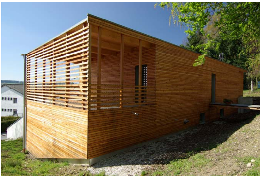
Weitgehend geschlossene Nordfassade mit östlicher Dachterrasse
