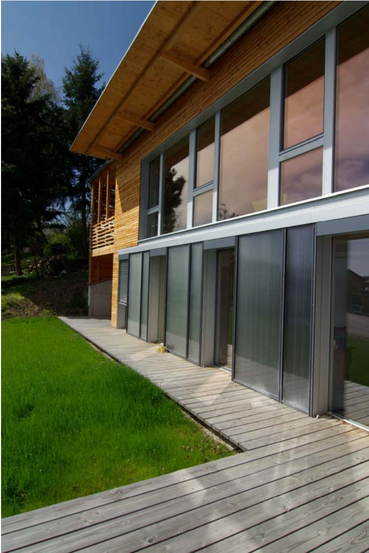
Südseite mit Fassadenkollektoren
