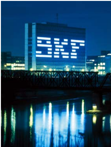
Hochhaus_b.Nacht.jpg: Das SKF Verwaltungsgebäude in Schweinfurt.
