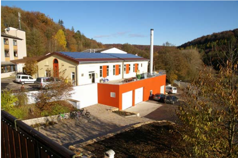
Das sanierte Wäschereigebäude inkl Photovoltaik
